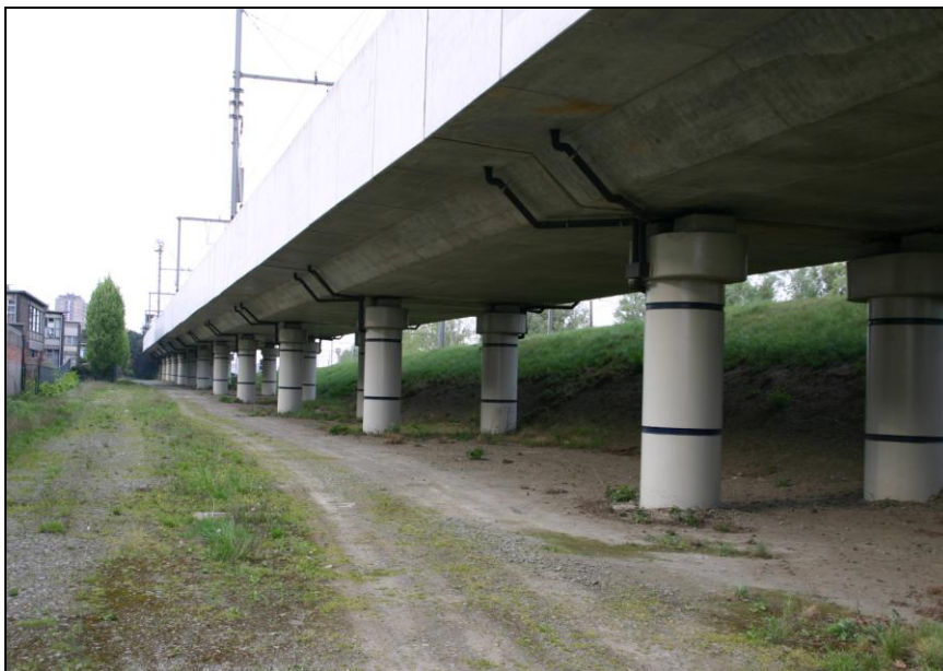
Figuur 14: Spoorwegbrug HSL4 in Antwerpen - Luchtbal
